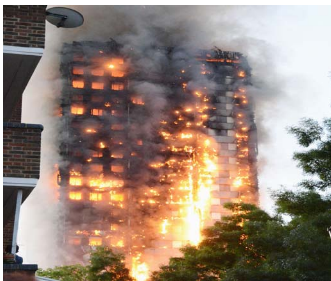
写真1 延焼中の高層住宅 1
